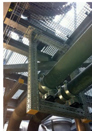
*Photo d'archive : Système modulaire à vis siFramo pour un montage rapide de la structure métallique secondaire*
