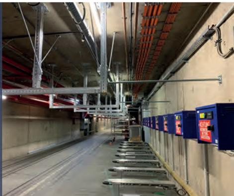
Sikla a fourni plus de 25 000 kg de matériel pour sécuriser les 1500 m de conduite géothermique dans des diamètres de DN 100 à DN 500. Il s'agissait notamment de 1 100 m de profil TP F 80, 400 m de profil TP F 100, 14 000 vis FLS F et 350 patins Simotec.
