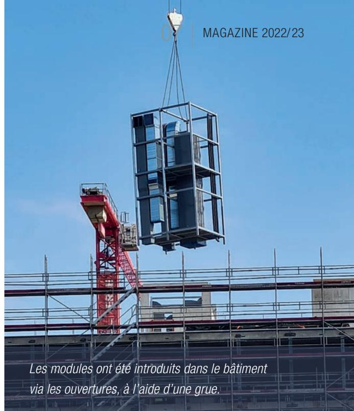
*Les modules ont été introduits dans le bâtiment via les ouvertures, à l'aide d'une grue.*
