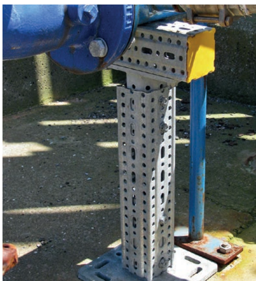
Support en T conventionnel et siFramo 80 Quelques mois après le montage
