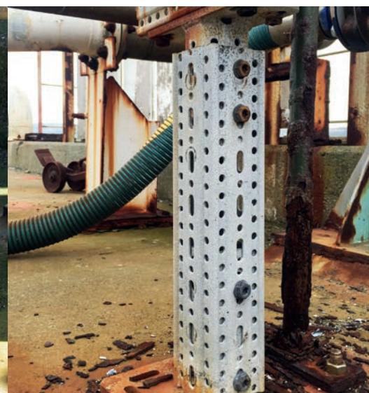
Après 6 ans d'exposition aux intempéries Offshore (CX)
