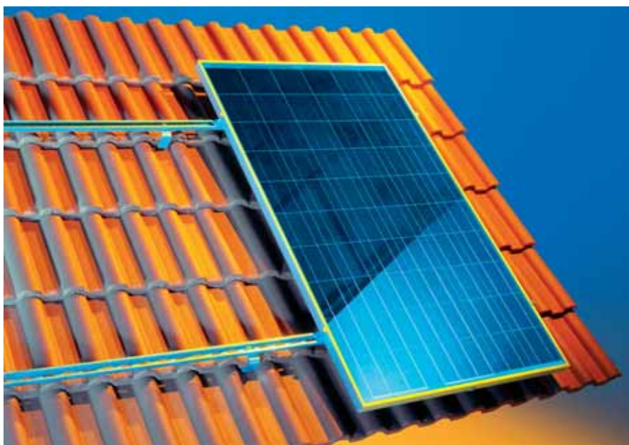
Montage sur toiture. Fixation du cadre sur charpente sous tuiles.
